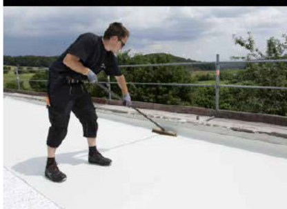
FLÄCHIGER KLEBSTOFFAUFTRAG - KEINE UNEBENHEITEN
